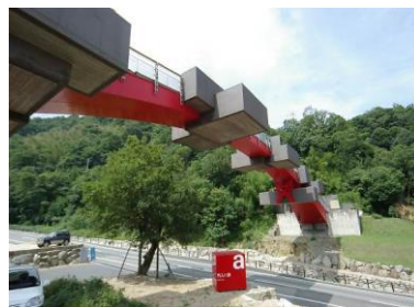
門入ブリッジ Monnyu Bridge
